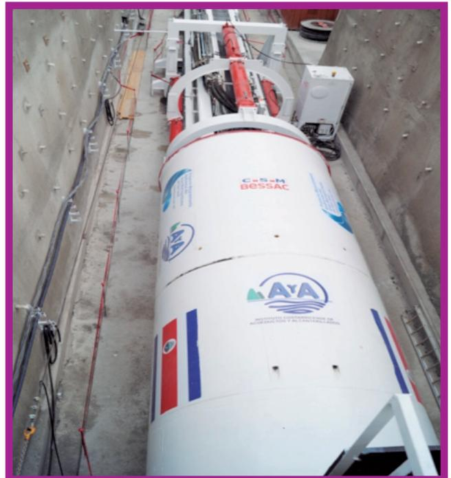
La Tuneladora "La Guaria" tiene una longitud en total de aproximadamente 70 metros, construyendo durante 18 meses el Túnel Trasvase.
