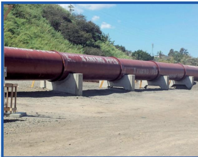
*Tubería en hierro dúctil y de fibra de vidrio será la utilizada en la construcción del Emisario, estas fotografías muestran algunos trazos que conforman los 3.115 metros de extensión.*
